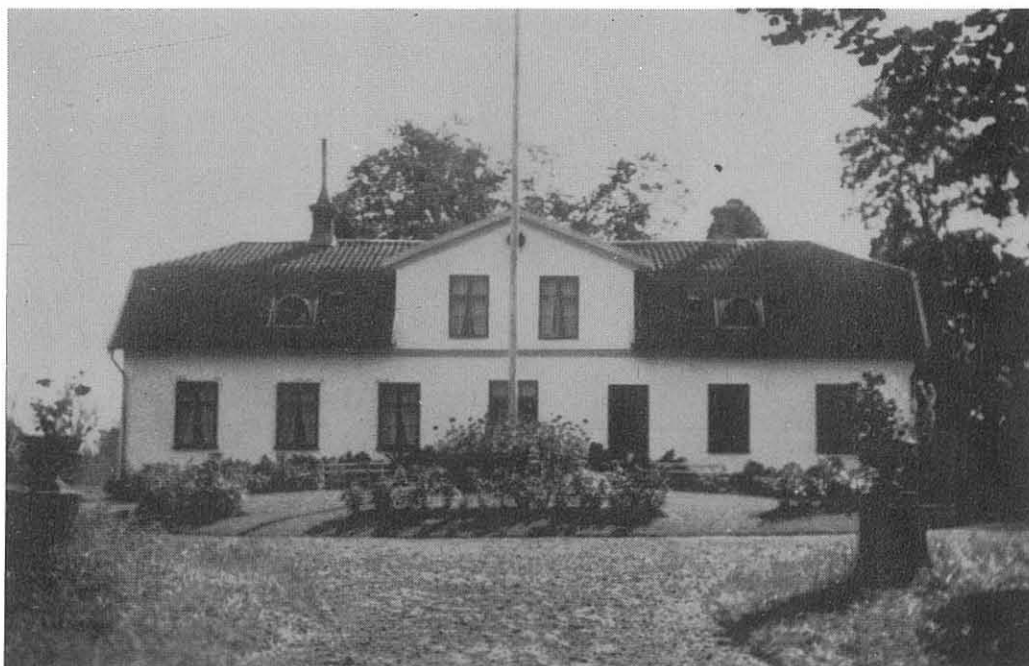
Huvudbyggnaden på Trueholm 1955. Huset är byggt på 1700-talet.
